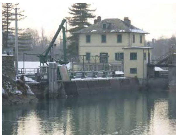
Fig. 2.4.21 - Particolare dell'opera di presa (a sinistra) e bocca di rilascio del DMV (a destra)
